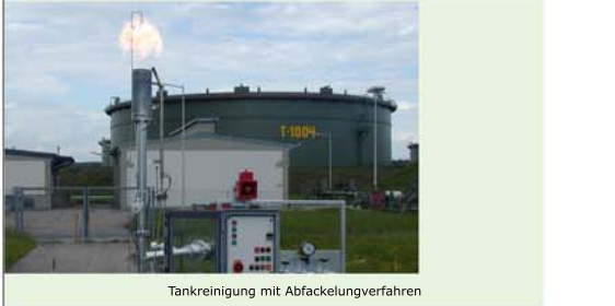
Tankreinigung mit Abfackelungsverfahren
